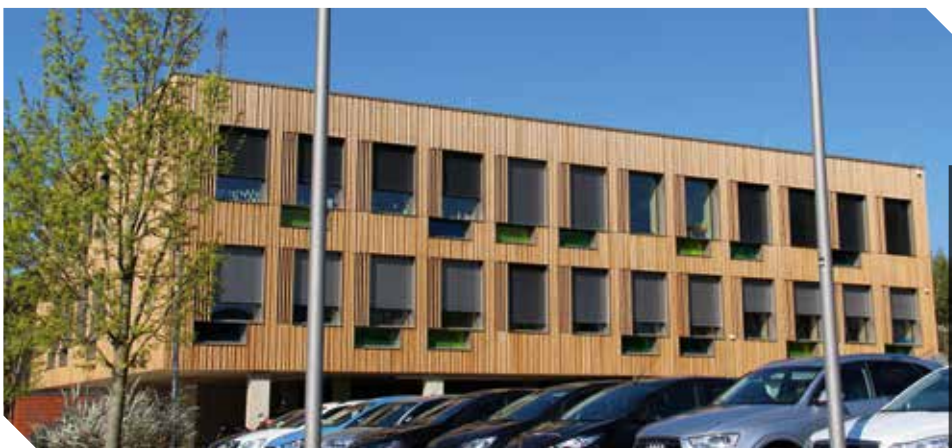
Le nouveau bâtiment au campus scolaire, photo datant du 18.04.2018.
