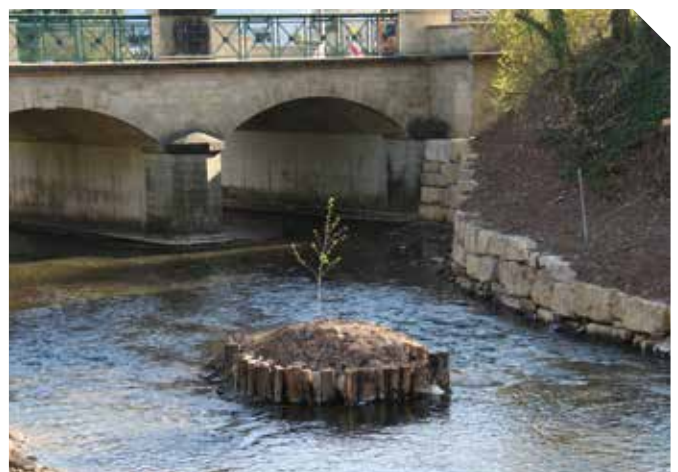
Projet «Aménagement de la berge gauche Syre et du Roudemerbaach le long du site du Veräinshaus à Olingen». Projekt „Umgestaltung des linken Syr-Ufers und es Roudemerbaach beim Veräinshaus in Olingen.“ Photo datant du | Foto vom 30.03.2018.
