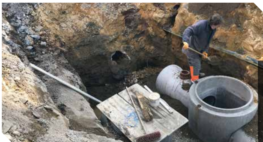
Travaux dans le cadre du réaménagement de la rue de Mensdorf à Roodt/Syre et de la rue de Roodt/Syre à Mensdorf, photo datant du 29.03.2018.
