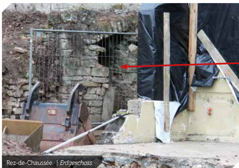
Site après les travaux de démolition, photo datant du 27.11.2018. Das Gelände nach den Abrissarbeiten, Foto vom 27.11.2018.
