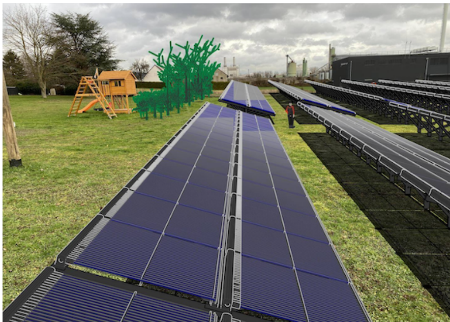
Luftaufnahme der Solarthermie-Großanlage der Stadtwerke Lemgo zur Erzeugung zukunftsweisender Fernwärme
