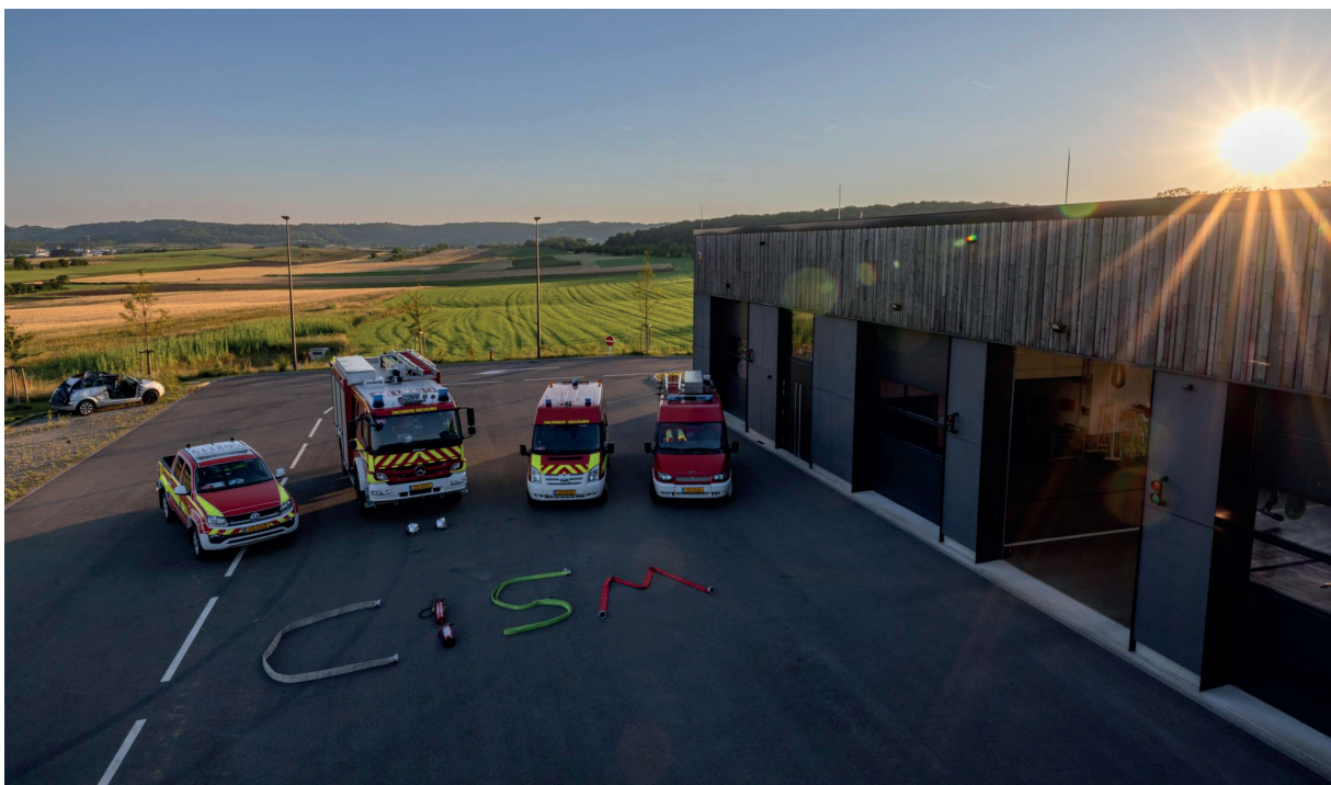
Foto: Feuerwache in Mensdorf (Quelle: Sam Behler)
