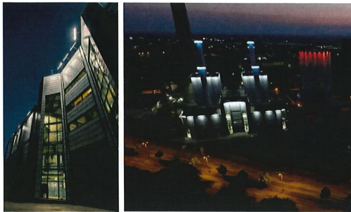
Abb. 44: Gas- und Biogaskraftwerk in Schwerin mit neuer LED Beleuchtung. Die Fassadenleuchten strahlen von oben nach unten, Himmelsaufhellung wird so vermieden. Ein positives Image der Stadtwerke soll durch die emissionsarme Beleuchtung transportiert werden.
