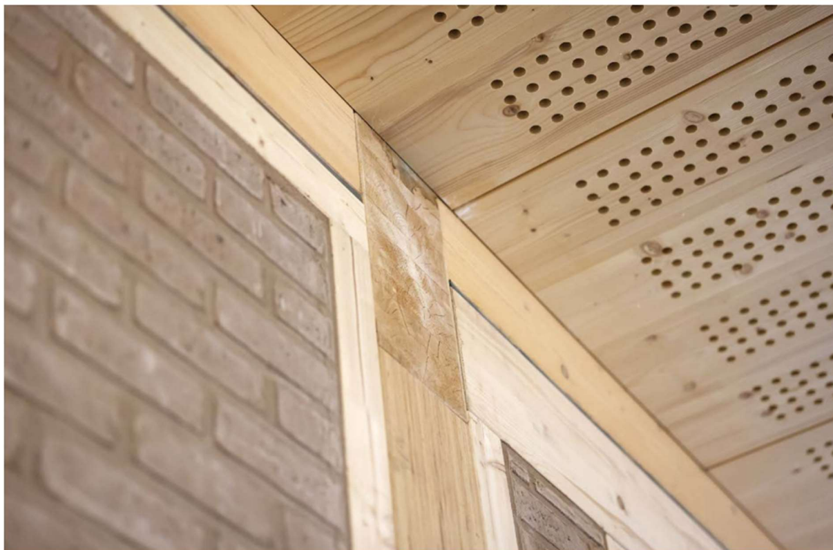
Abbildung 47: Aufbau der neuen Crèche von innen (IetzBetz Gemeindebuet 2025 N°1)
