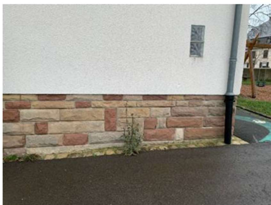
Soubassement en pierre naturelle
