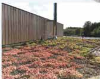
Dachbegrünung auf der Bäckerei in Rodt/Syr. Eigene Aufnahme.
